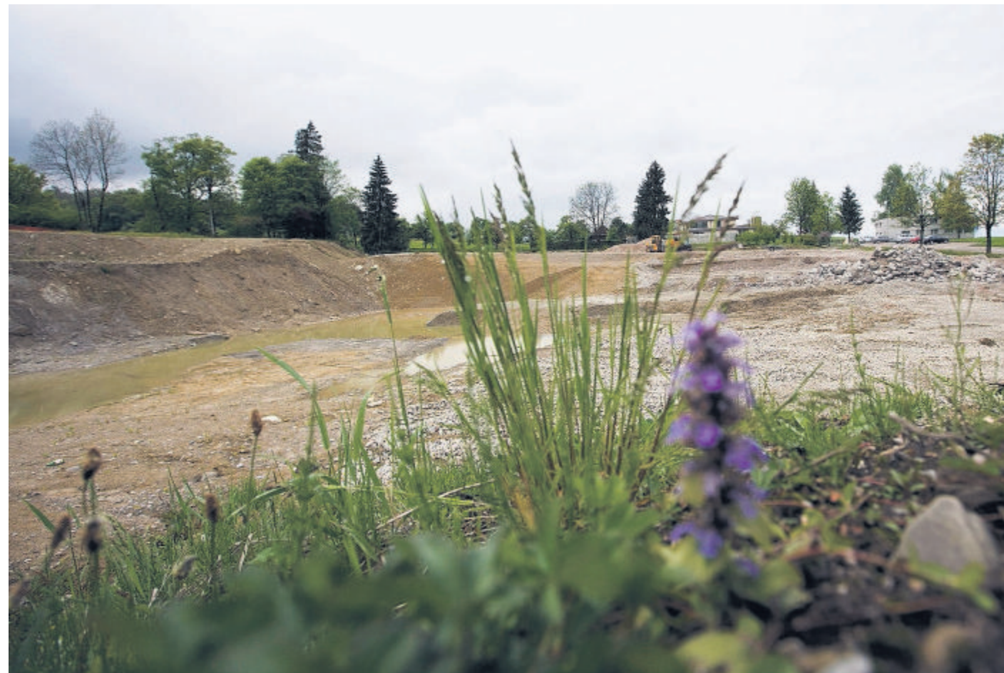
Wo früher das alte Kurhaus Oberwaid stand, sollen bald die Arbeiten für den Neubau beginnen.
